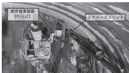
図一1 Pi-Lif および AGF-Sq 施工状況
