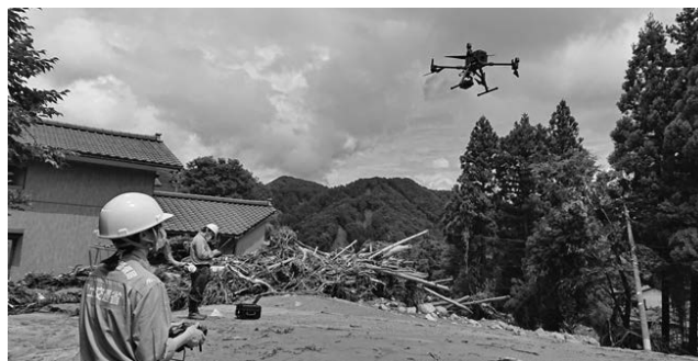
写真—1 UAV を活用した調査
