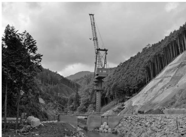
写真—12 タワークレーンのアースカラー塗装
