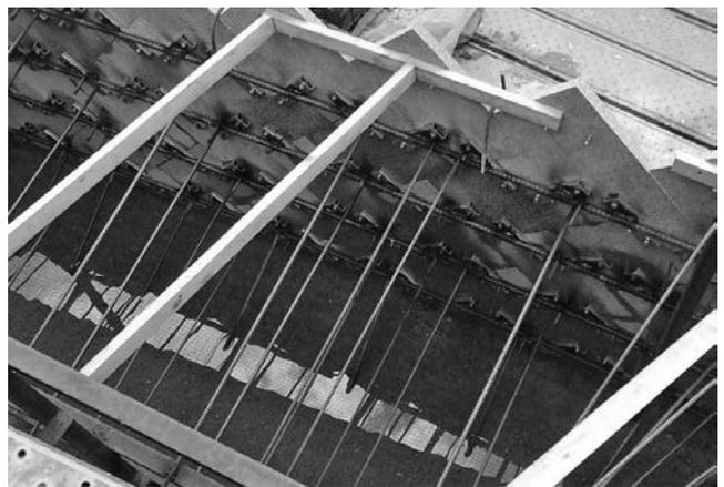
写真一八 フック筋の設置
