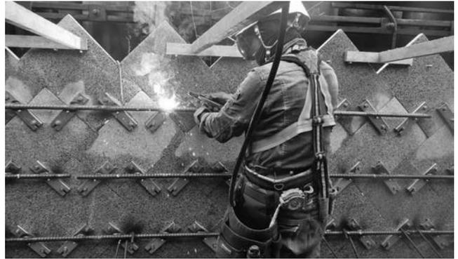
写真一七 定規用鉄筋の設置
