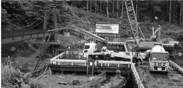
写真—12 打設状況（ポンプ車手前は希望大橋）
