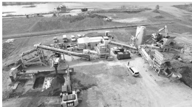
写真—8 現場全景（草根ゴミ分別改良事例）
