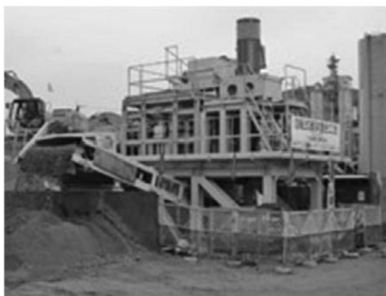
写真—4 現場全景（軟岩破碎混合改良事例）
