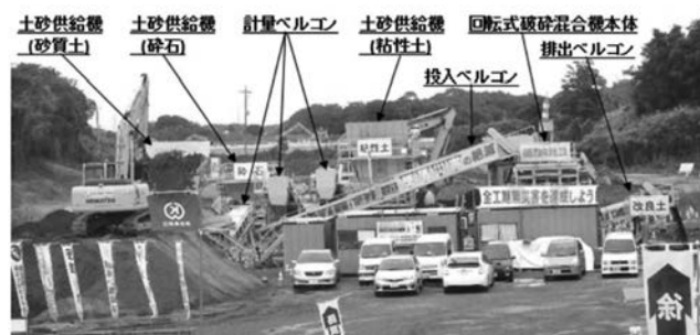
写真—10 現場全景（鬼怒川激特事業における施工事例）
