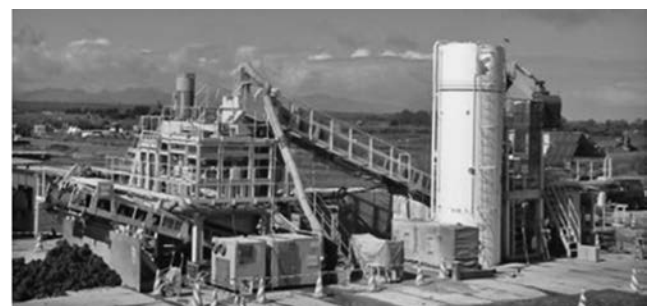
写真—1 現場全景（高含水比粘性土改良事例）
