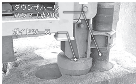
写真—1 スロット孔の連続穿孔状況
