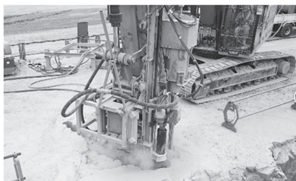
写真—3 スロット孔の連続穿孔状況
