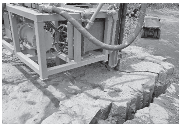
写真—5 パッカー割岩状況
