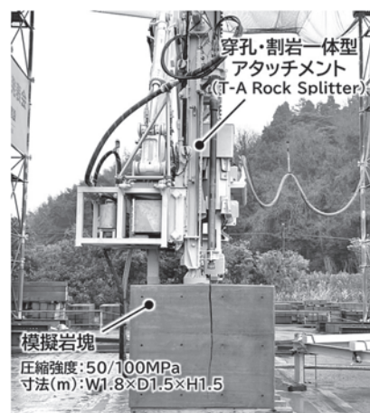
写真—6 模擬岩塊の割岩状況
