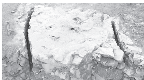
写真—4 連孔スロット形成完了
