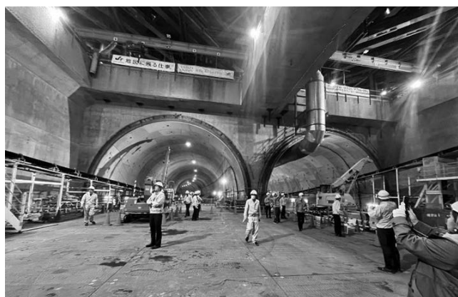
写真一 2 回転立坑内状況
