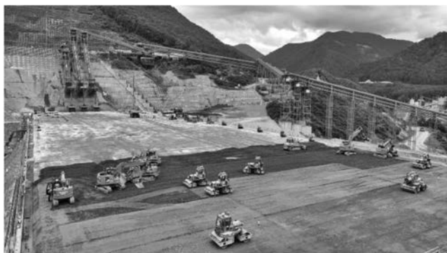
写真—1 2023 年成瀬ダム自動化施工状況
