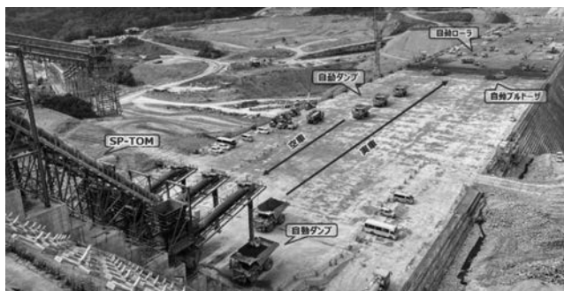
写真ー2 自動ダンプによる材料運搬
