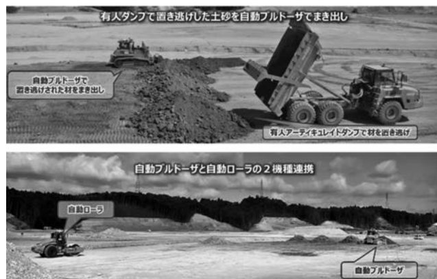
写真—4 造成現場での自動化施工稼働状況
