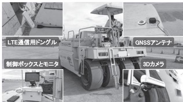
写真-4 機材設置状況
