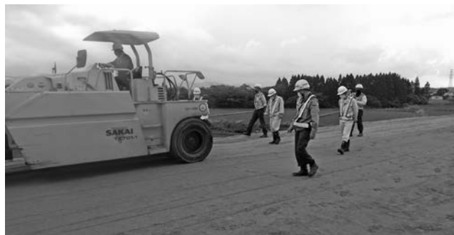
写真—1 ブルーフローリング試験状況（従来方法）
