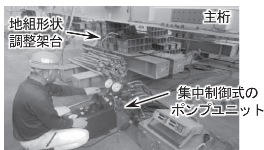
図－8 地組形状の調整状況
