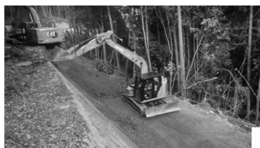
丁張間の目印がない箇所もモニターを見て正しい掘削が行え 若手オペの育成もできた
