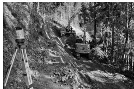
ICT 建機は2台導入し生産性向上を図る
