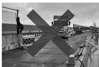
高速道路本線からの搬出入
