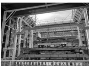
リフトアップ式揚重設備
