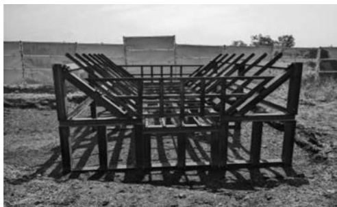
写真—5 高速焼却装置「モヤッシー」
