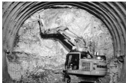
写真-2 遠隔操作油圧ブレイカ
