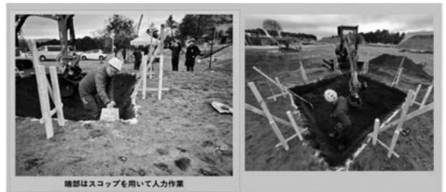
写真一3 手元作業員の人力作業
