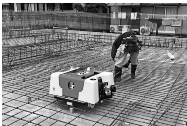
写真—6 鉄筋結束ロボット「トモロボ」
