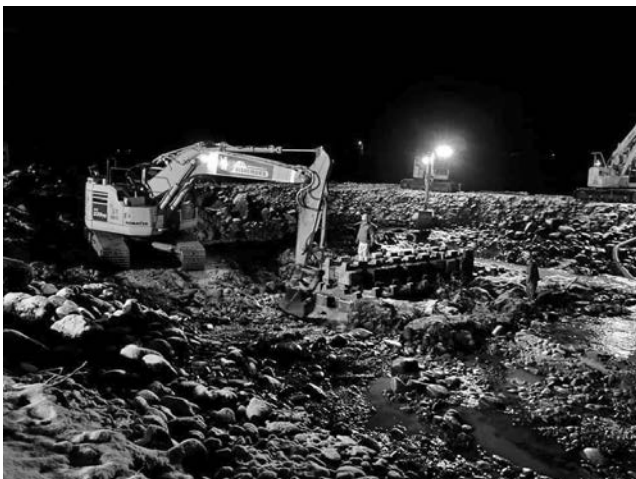
写真—3 深夜の突貫工事
