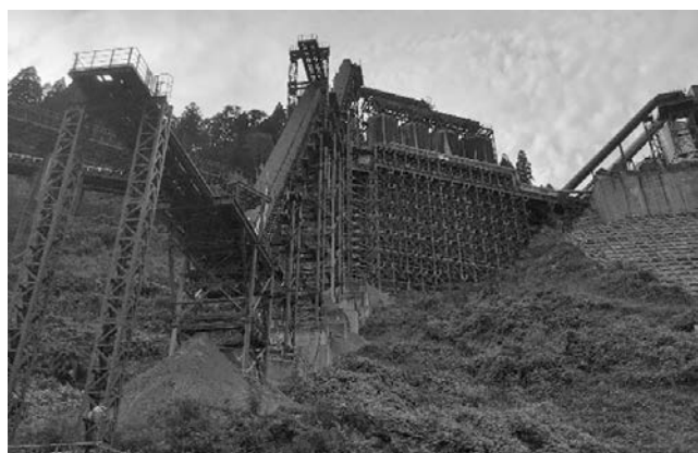
写真—3 急傾斜ベルトコンベア
