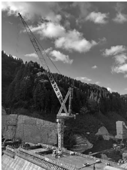
写真—6 タワークレーン
