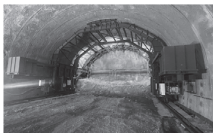
図—2 Smart Lining System™ Type2用スライド型枠
