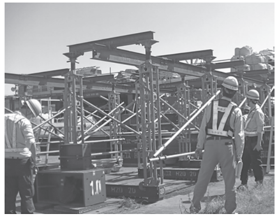
写真-3 ホーム横桁架設試験
