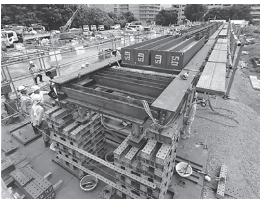
写真-2 工事桁扛上、横移動試験
