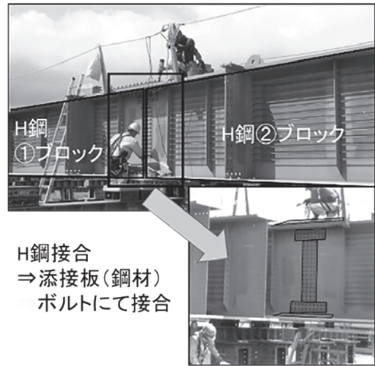
図-7 添接板を使用した現場接合
