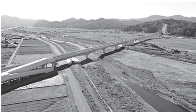
写真-6 高炉スラグセメント活用した橋梁 (北陸新幹線・日野川橋梁)
