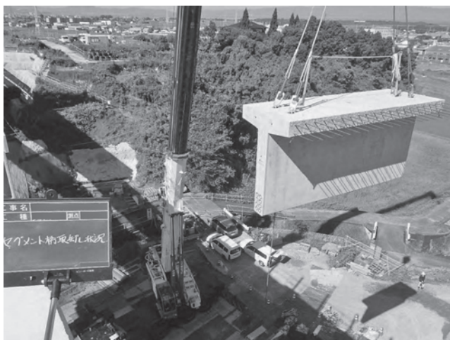
写真—3 プレキャストによる橋梁工事
