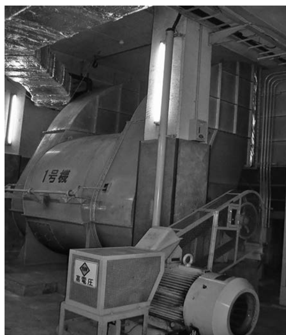
写真—1 換気機の設置状況
