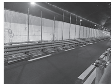
図-3 仮設防護柵設置状況
