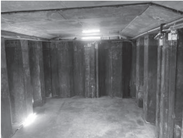
写真一4 完成後の地下空間
