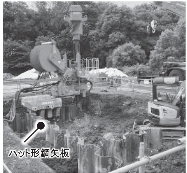
写真-1 鋼矢板圧入状況
