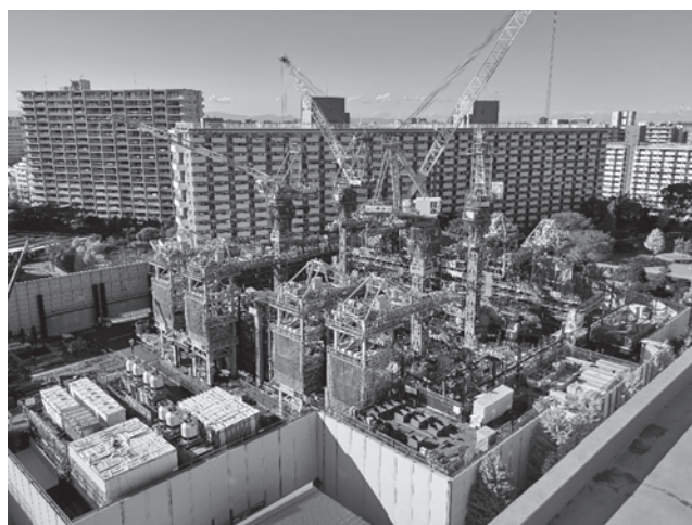
写真一 1 現場施工状況全景
