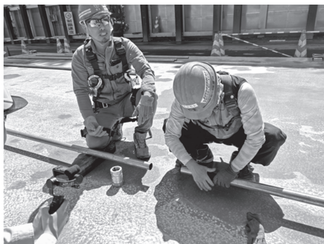
写真—3 配管組み立て状況—1 (アンテナユニット取付け)
