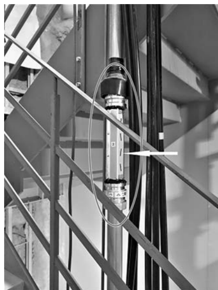
写真-1 アンテナユニットの接続状況
