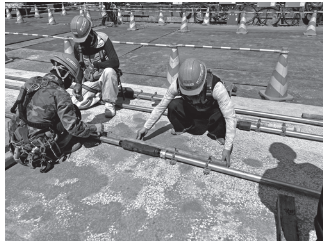
写真—4 配管組み立て状況—2 (分割にて準備)
