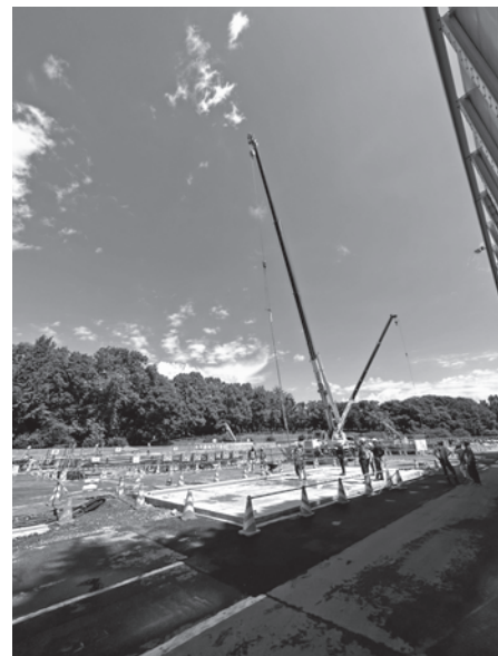
写真—5 配管つり上げ状況
