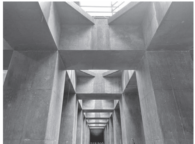
写真一2 調節池内部 梁型・柱型状況
