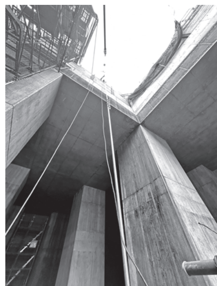
写真—6 配管吊り下げ状況
