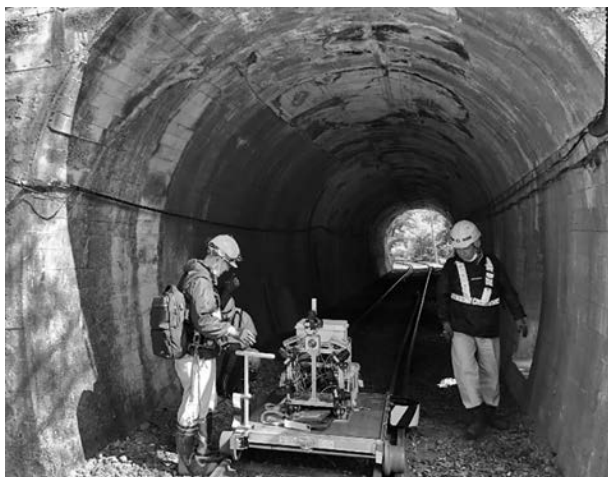
写真—5 鉄道トンネルでの試験状況
