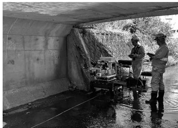
写真—7 ボックスカルバートでの試験状況
