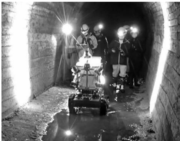
写真—4 馬蹄形水路トンネルでの試験状況
