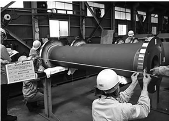
写真一二 鋼管柱の長さ測定状況
