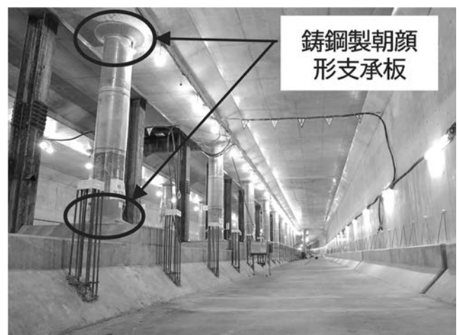
写真—1 合成鋼管柱の設置状況
