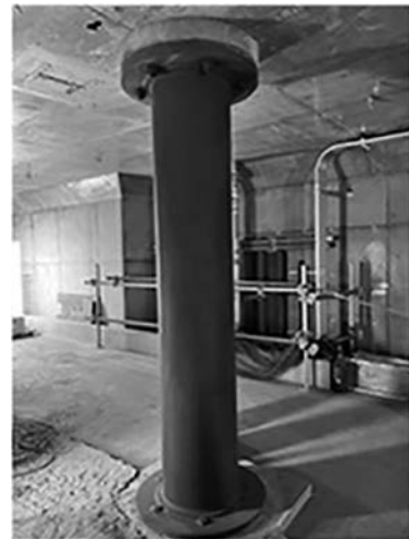
写真一四 鋼管柱設置完了
