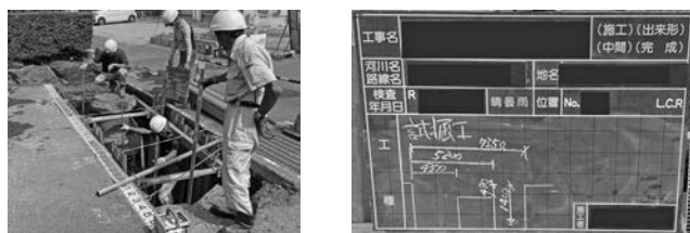
図-2 埋設状況記録
