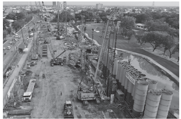
写真-1 ノースアベニュー駅 地中連続壁施工状況
