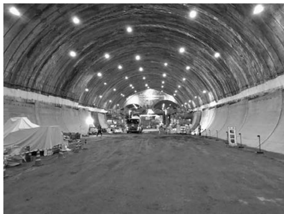
写真—2 トンネル坑内
