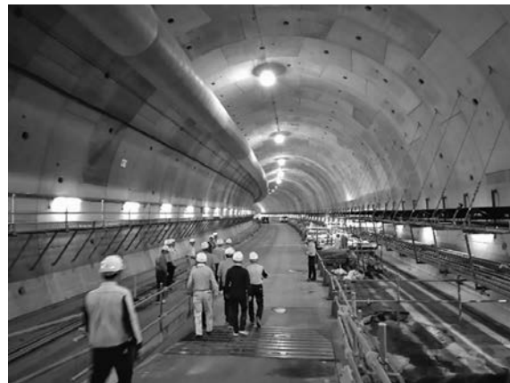
写真－10 シールドトンネル坑内
