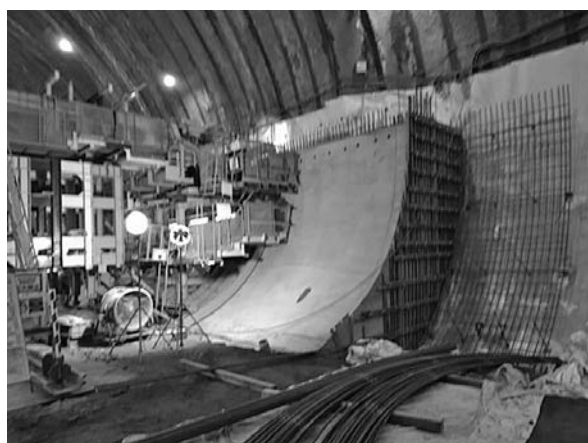
写真—3 作業状況
