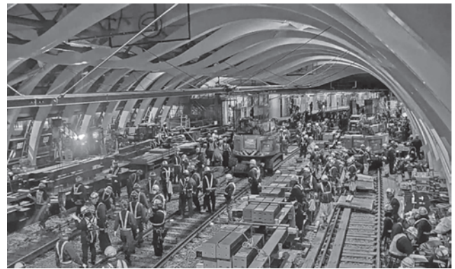
写真-1 渋谷駅移設切替工事実施状況
