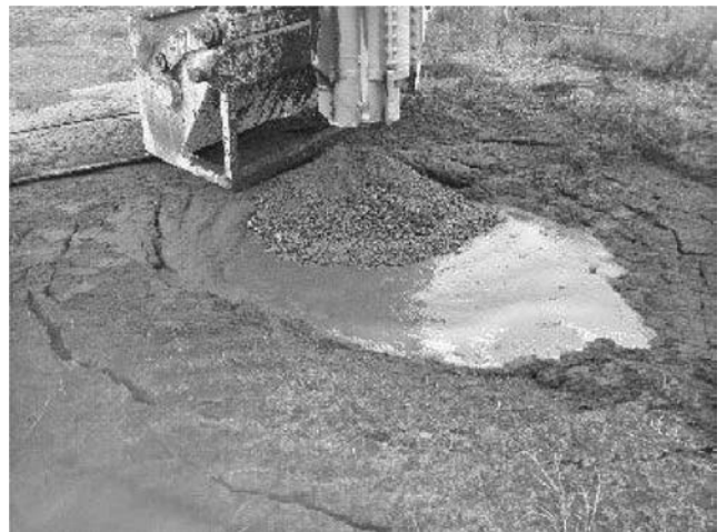
写真-2 改良後の地表面の状況
