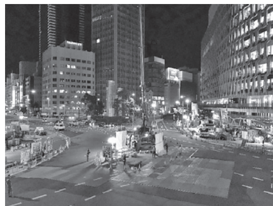
写真一1 交差点を占有しての地盤改良施工状況
