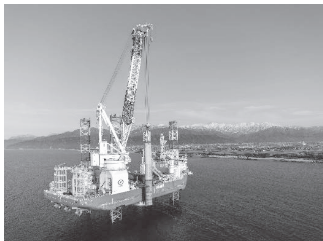
写真—8 入善沖洋上風力 風車基礎打設
