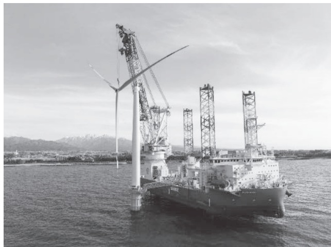
写真—9 入善沖洋上風力 風車据付
