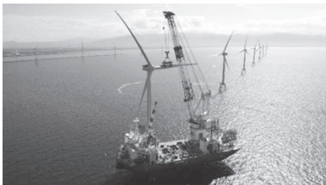
写真—10 石狩湾新港洋上風力 風車据付
