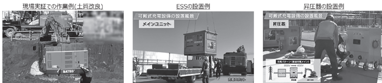
図ー5 現場実証を通じた電動建機および周辺設備の実例
