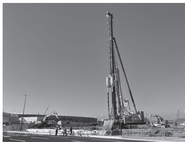
写真一 三 機械攪拌工法用途での施工状況
