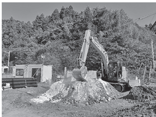
写真—1 低炭素型土質改良材 C の使用状況
