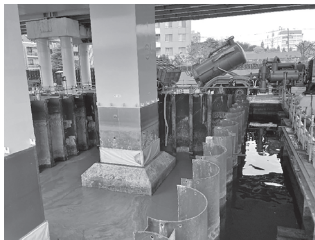
写真一 二 流動化処理土用途での施工状況
