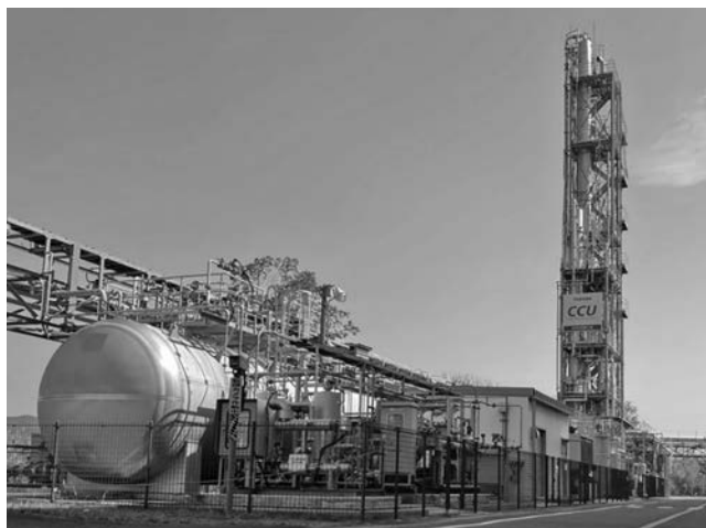
写真—4 佐賀市清掃工場 CCU
