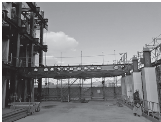
写真—3 耐火集成材柱の養生
