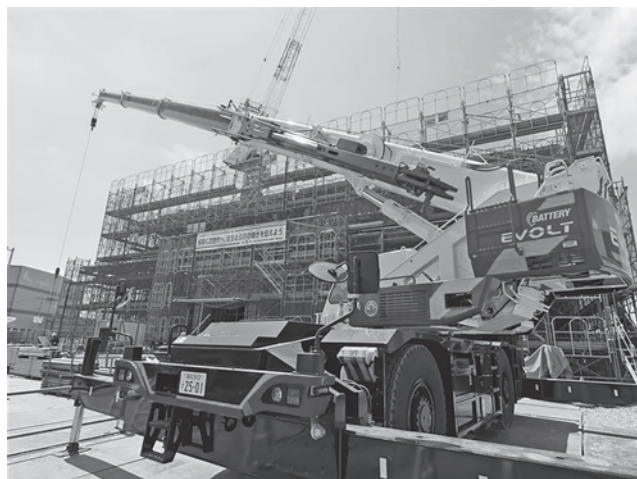
写真-3 (株)タダノ製 25t電動ラフタークレーン
