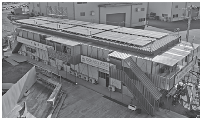
写真—4 仮設事務所全景
