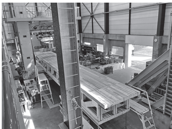
写真—1 大スパン床ユニット
