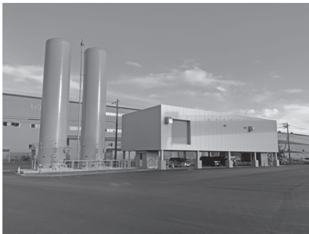
写真—3 水素棟外観
