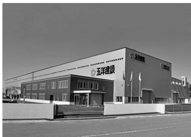
写真一 2 事務所棟外観
