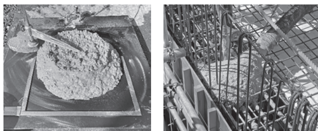
写真—7 CELBICのスランブ試験と打設状況
