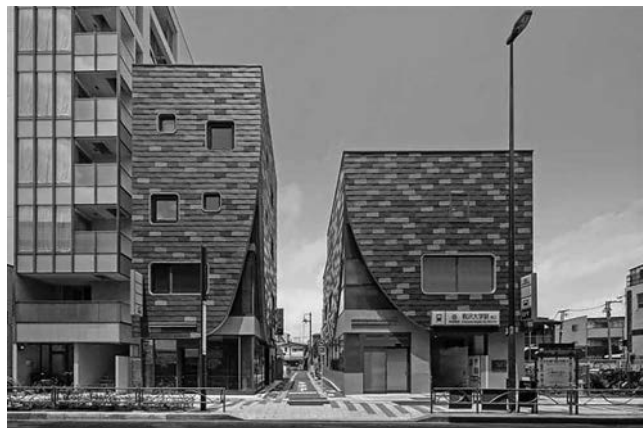
写真—4 木造4階建ての駒沢大学駅西口2ビル（左）
