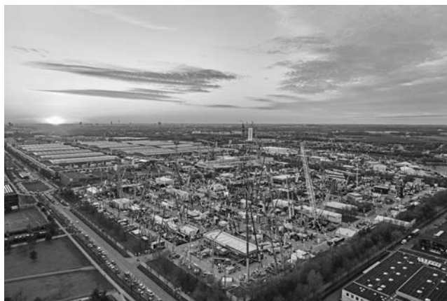
写真－１ 展示会場の全景（主催者 HP 掲載写真より）
