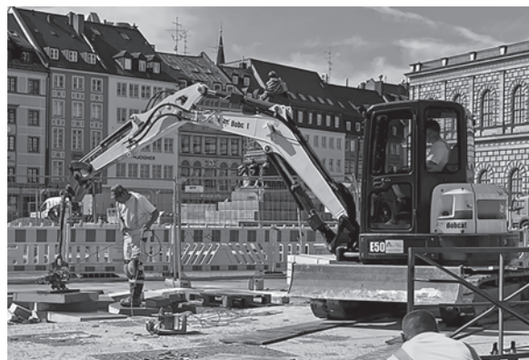
写真—40 ミュンヘン中心部での改修作業（アタッチメントでブロックを設置している作業員）
