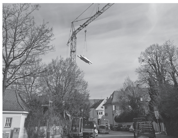
写真—41 ミュンヘン郊外の住宅のリニューアル工事（電動のジブクレーン）
