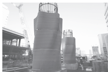
ペDESTリアンデッキの柱（非構造部材型）
