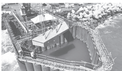
岩盤型潜水突堤（構造部材型）
