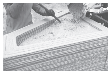
重力式擁壁（構造部材型）
