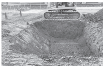
写真—3 自動掘削による出来形（ケース 1）
