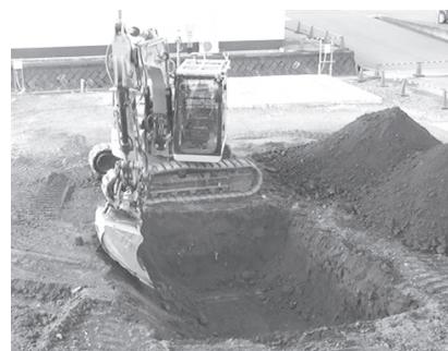
写真—2 チルトローテータを使用した斜面掘削状況
