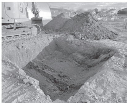
写真—5 自動掘削による出来形（ケース3）
