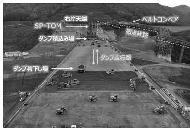
写真—1 堤体全景と材料運搬システム
