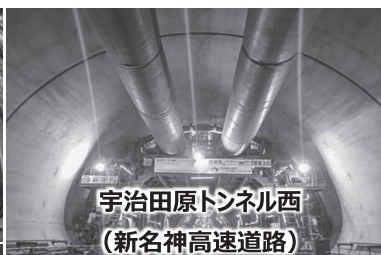
宇治田原トンネル西打設状況
