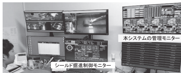
写真-1 中央制御室での掘進と本システムの監視操作【実証施工】
