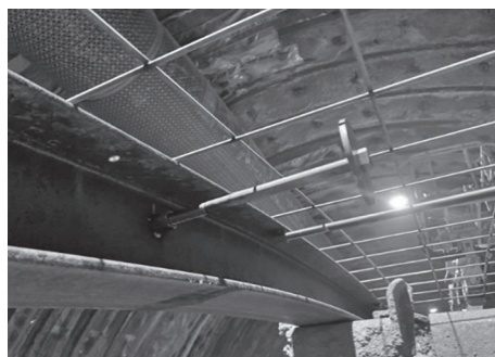
写真一2 金網・頭付きアンカー
