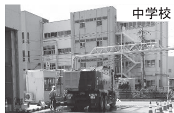
写真一2 発進基地正面の中学校
