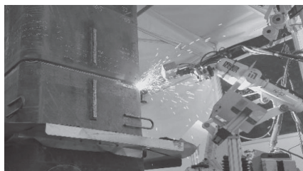
自動溶接中の状況
