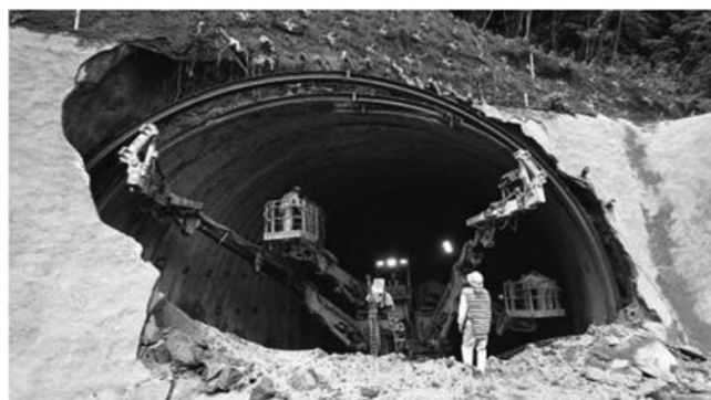
図—21 開発技術による斜坑門施工状況
