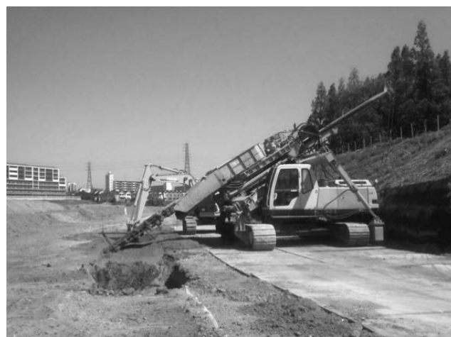
写真-1 地中控え護岸壁施工時のTRDⅠ型*
