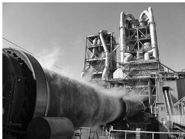
写真一 6 サスペンションプレヒーターとロータリーキルン（地上から）
