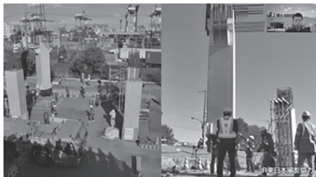
写真—3 建設会社提供動画（鉄建建設株）
