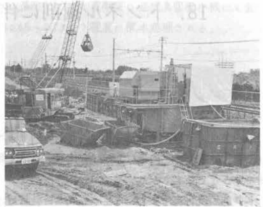
図-4 リバー工法の泥水処理 施工状況
